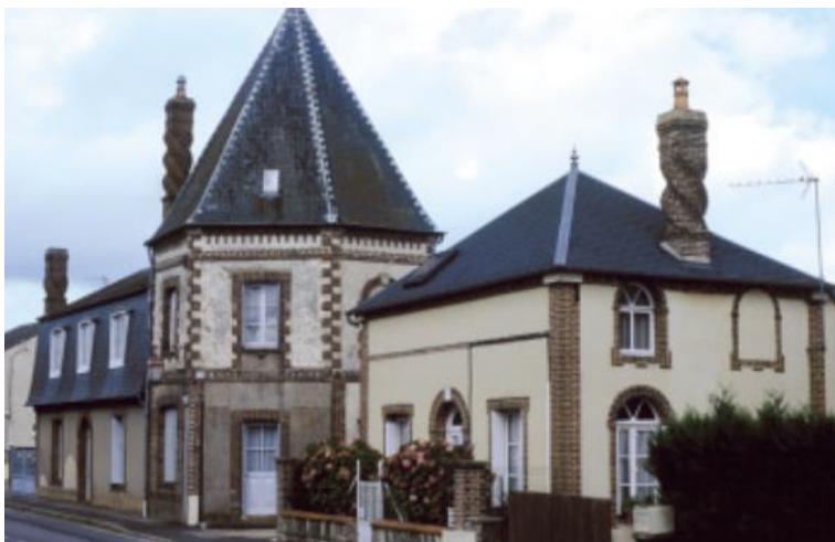
Bâti traditionnel à Saint-Ouen-sur-Iton coiffé d'un toit en tuiles avec les briques rouges en guise d'encadrements et de cheminées (source : Inventaire Régional des paysages)
