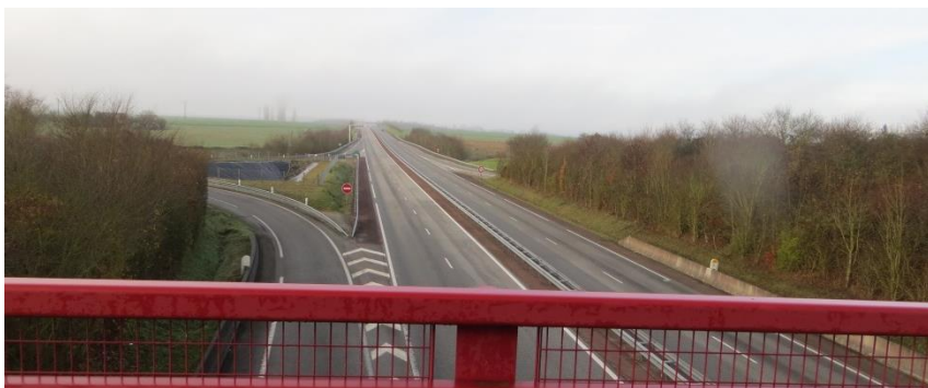
Passage sur la D926 au sud de L'Aigle, une véritable rupture marquant le paysage (source : Even conseil)
